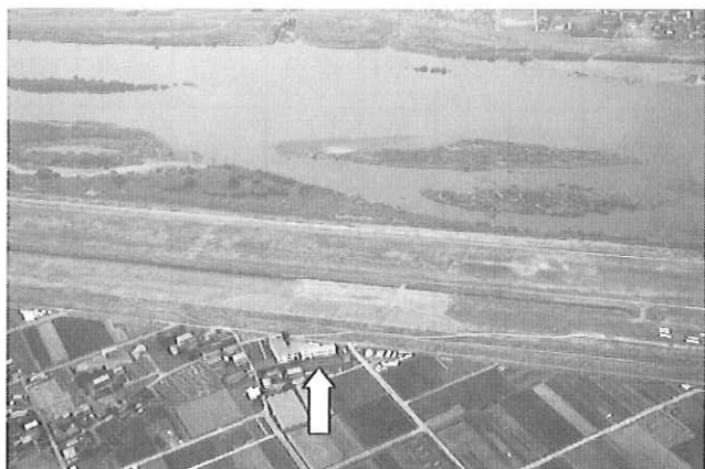
① めぬま 妻沼訓練所の格納庫棟
