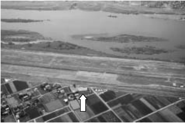
めぬま 妻沼訓練所の格納庫棟
