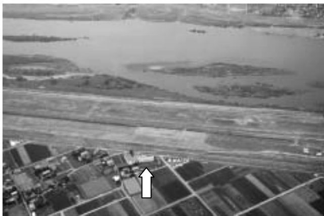
めぬま 妻沼訓練所の格納庫棟
