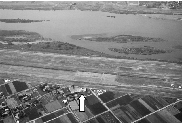
① めぬま 妻沼訓練所の格納庫棟
